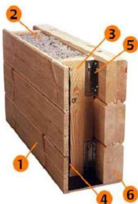
Interiérová stěna s dodatečnou izolací
